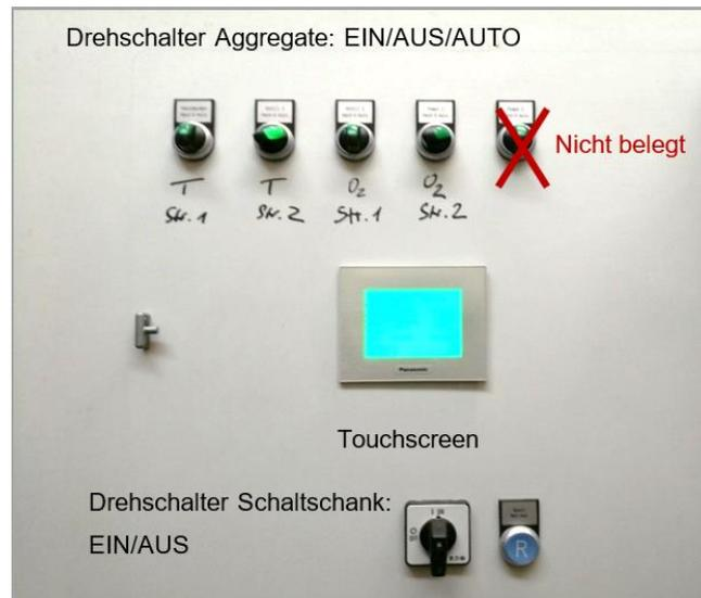
**Bild 7:** Frontseite des Schaltschranks
